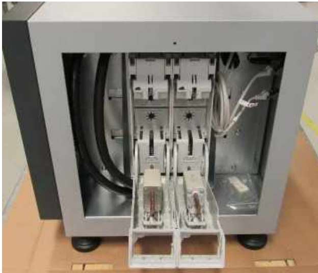
Abbildung 4-13 Batteriespeichersystem, Seitenansicht, Leistungstrenner gezogen
